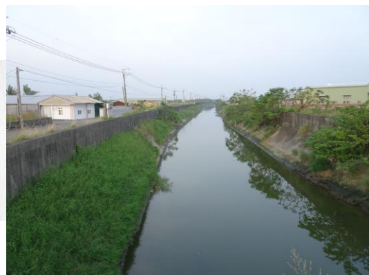
圖 70 三爺宮溪的所屬人工水道現貌二，臺南州曾文郡大內庄基地
