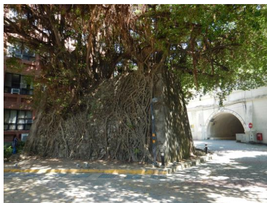
圖38 海上挺進第23戰隊西子灣基地壽山洞舟艇壕洞口防爆牆現貌
