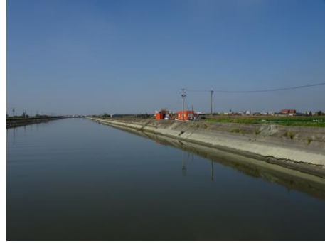
圖 94 荷芭嶼大排原海上挺進戰隊基地現況
