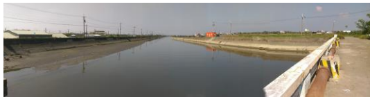
圖 93 荷芭嶼大排原海上挺進戰隊基地現況
