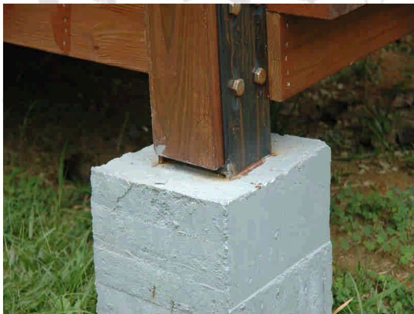
圖 2. 木柱在基礎部份不與土壤直接接觸，改以水泥阻絕。
